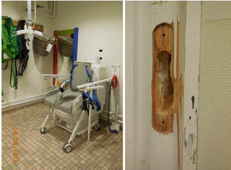
Handicappedtoilet (l) ved centerafdelingen og defekt lås på dør
