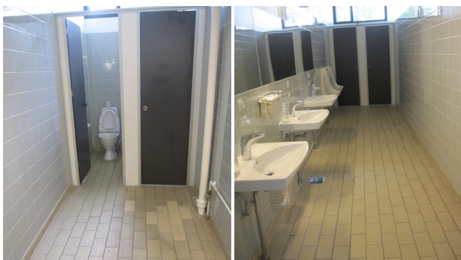
Toiletter tæt på gymnastiksalen
