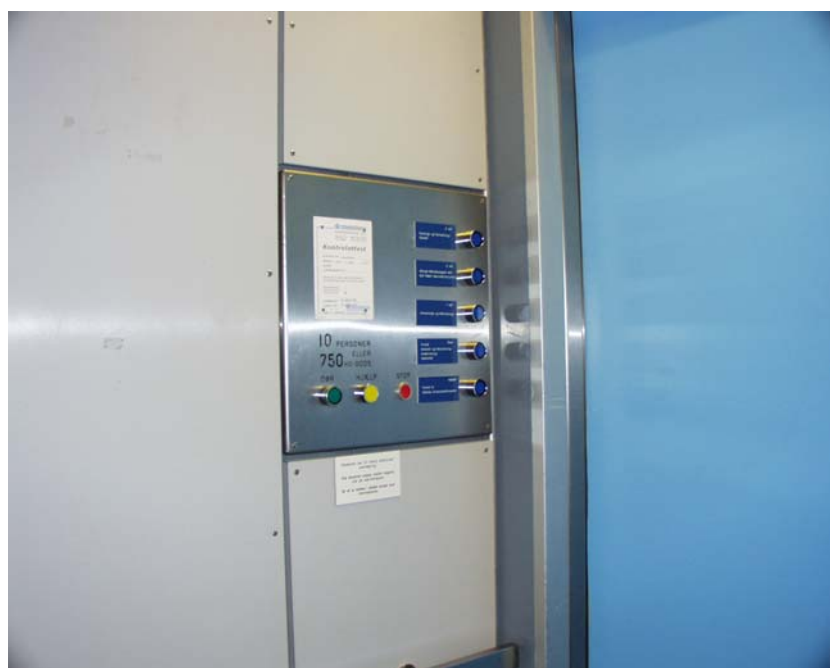
Illustration 20 Winsløvparken, elevator i bygning 21
