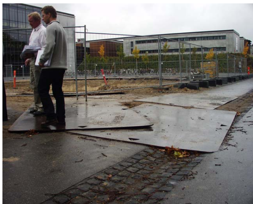
Illustration 2 Udgravning ved hovedindgangen
