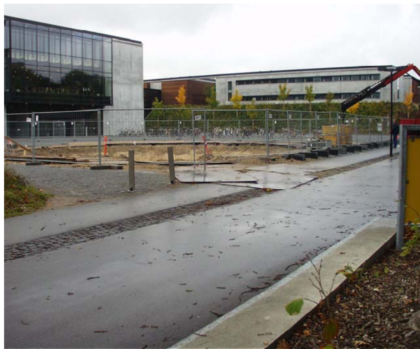
Illustration 1 Udgravning ved hovedindgangen
