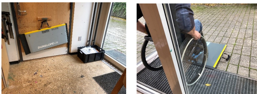
Udgang fra sløjdlokalet i kælderetagen
