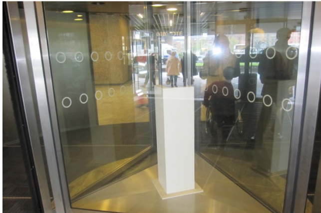
Fig. 5 – markeringer på rotunden ved hovedindgang.
