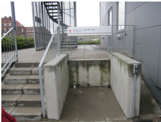
Fig. 19 – trappe til opgang 85.
