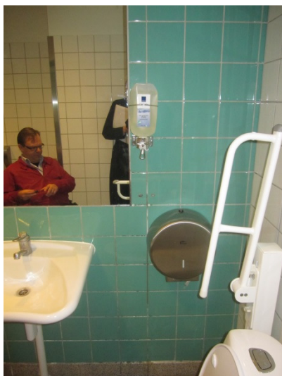
Fig. 11 - sæbedispenser på handicptoilet.
