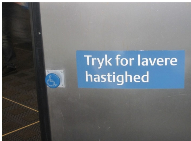
Fig. 4 – skiltning ved svingdør.
